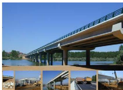
*Ejemplos de diferentes viaductos construidos únicamente con elementos prefabricados*
