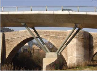
*“Puente del río Boeza” Losa postesada con soportes tubulares de acero.*
