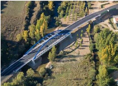
*Doble arco atirantado metálico sobre el río Porma*
