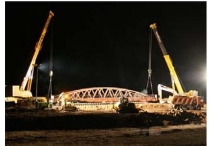
*Celosía metálica para una línea ferroviaria en construcción*
